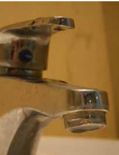
Instal·lació difusors a les aixetes del restaurant Puerto Limon.
