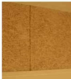
Aïllament de sostres a l'hotel Alga.
